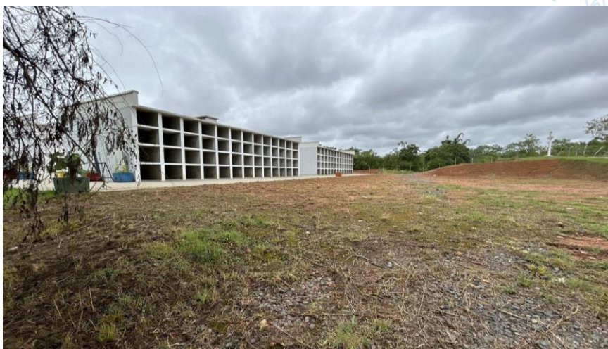
Foto 3: Área destinada à construção dos Lóculos da "Fase 2"
