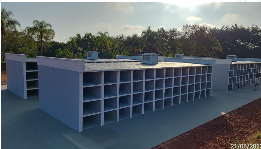
Fotos 1 e 2: Lóculos construídos na "Fase 1"
